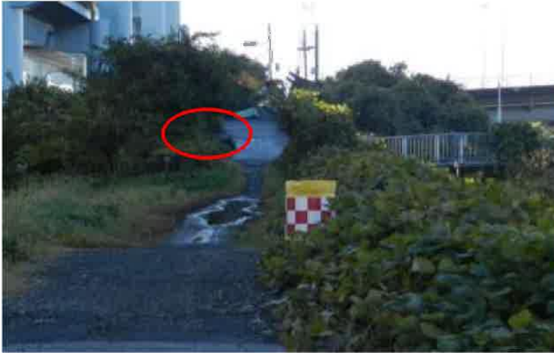
神川橋東信号 相模川左岸堤防道路 赤丸がゴミ投棄場所
