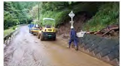
<土砂除去作業>
