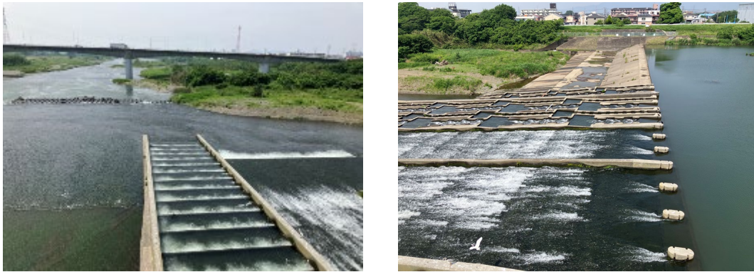
図 22 寒川取水堰の魚道
