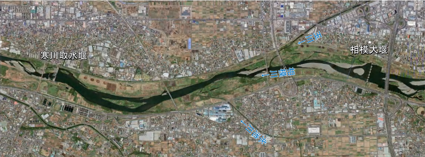
図-委 2 調査範囲（相模大堰～寒川取水堰）
