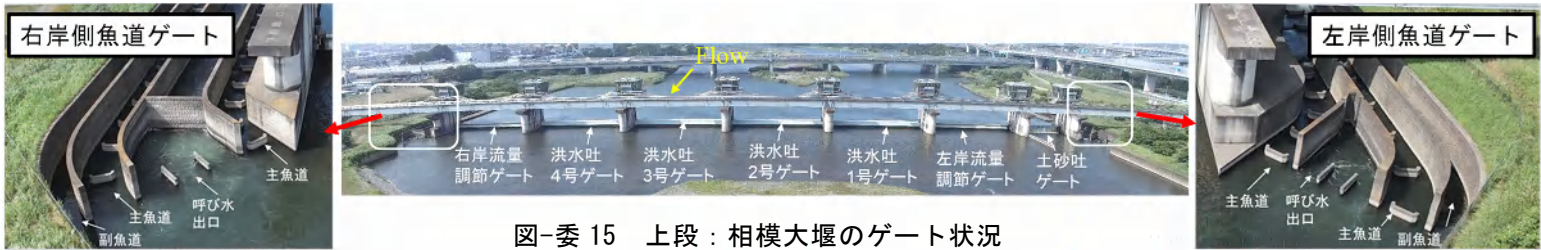
図-委 15 上段：相模大堰のゲート状況
