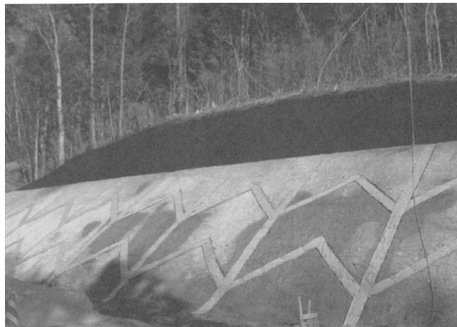
【図Ⅲ. 6-20 切土のり面に設置する暗渠排水工の例】 『のり面保護工施工管理技術テキスト（改訂版第3版） （一社）全国特定盛土保護協会 平成30年5月』
