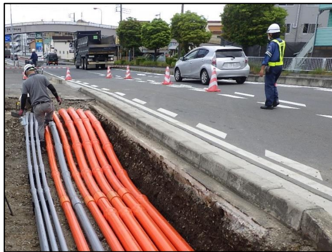
電線を地下へ埋設するための管路を敷設する様子
