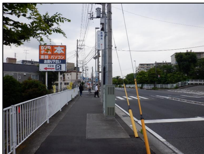
② 国道 412 号（松枝～林）電線地中化工事区間
