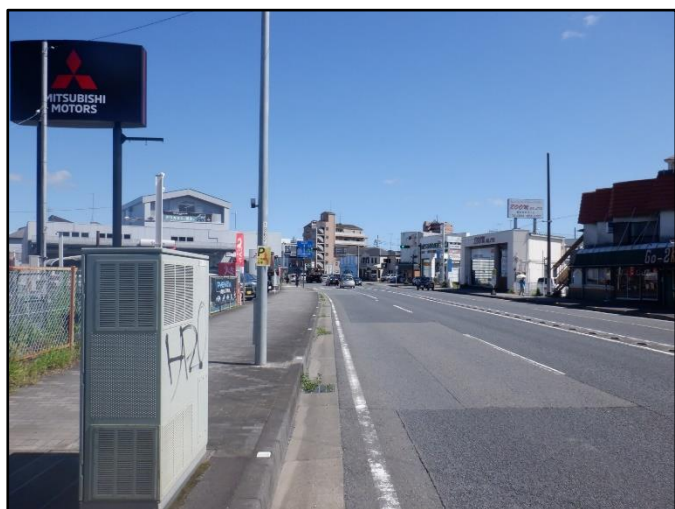
① 国道 412 号（水引～松枝）電線地中化済み区間
