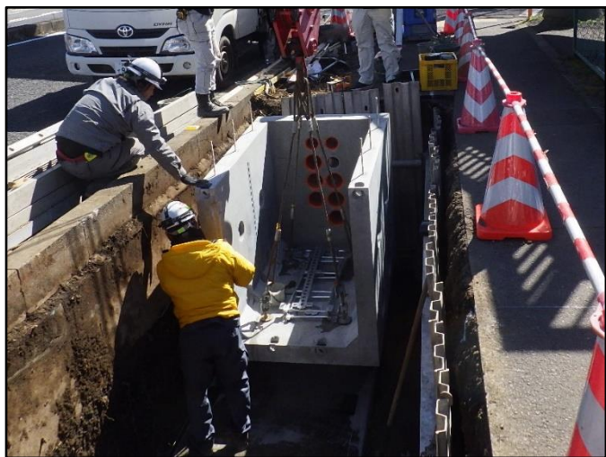
埋設管路・ケーブルを管理する箱を設置する様子
