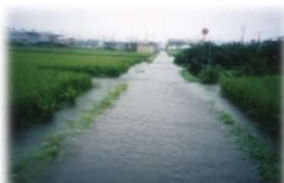
豪雨により溢水
