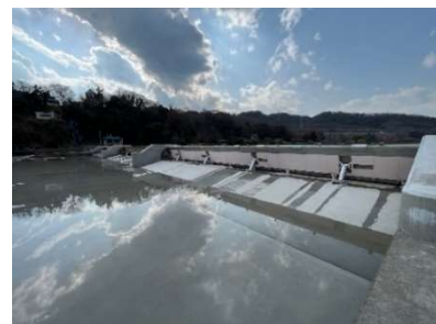
転倒ゲートの完成状況
