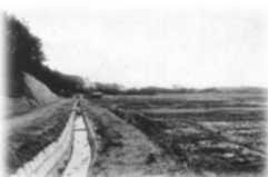
建設前の水路
